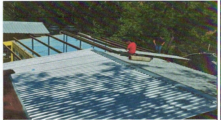
Foto 2: Colocacion de las lámina troquelada calibre 24 en cocina e aulas
