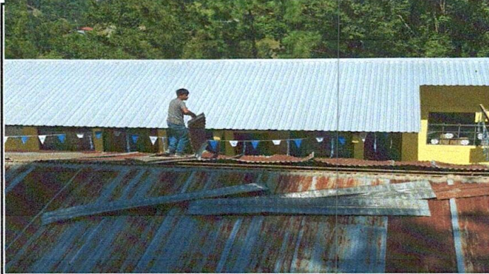
Foto1: Sustitución de las laminas de las aulas
