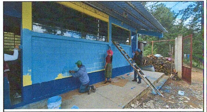
Foto 4: Pintado de las aulas exterioro e exterioro
